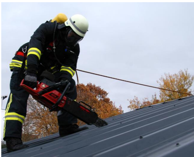
Abb.1: Einsatz der Rettungssäge zur Schaffung einer Abluftöffnung.
